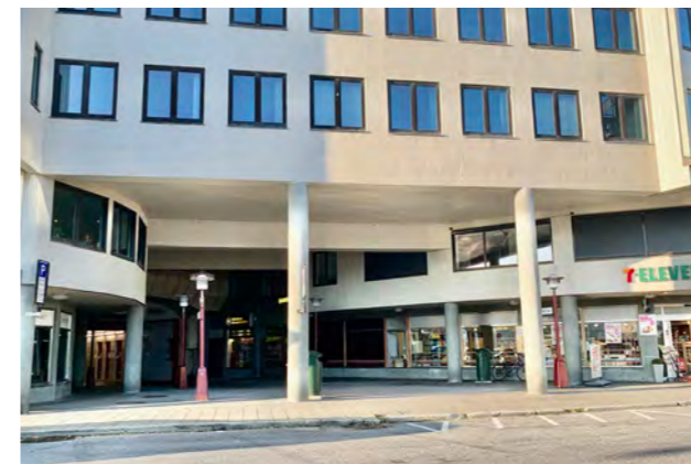
3. Utsikt fra gateplan mot nord. Herfra går en tunnel til gågata.
